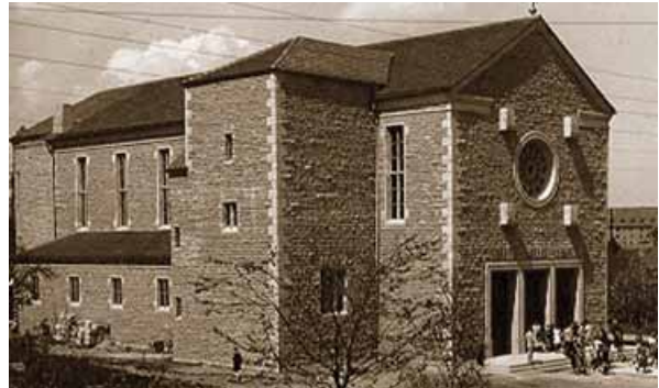
Der Kirchenneubau noch ohne Turm
