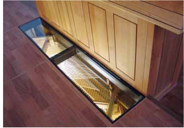
Ein beleuchtetes Sichtfenster hinter dem Spieltisch bietet Einblick in die Trakturwege
