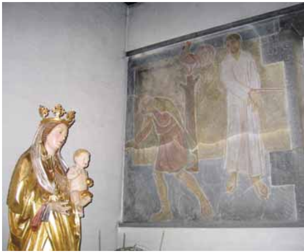
Der von Salpeter beschädigte Kreuzweg
